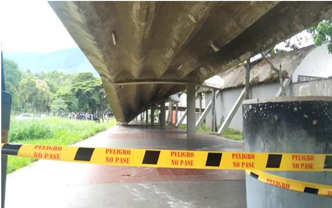
Figura 12- Techo de la caminería n.º 5, frente a la Facultad de Humanidades de la UCV.
