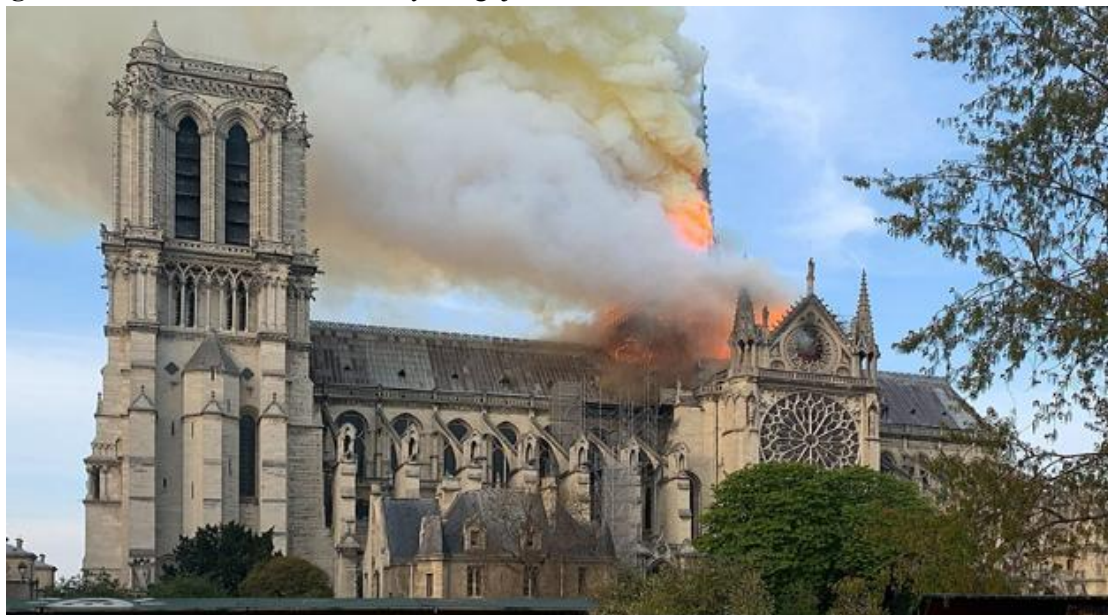
Figura 11 – Incendio de la cubierta y la aguja de la Catedral de Notre Dame de París.
